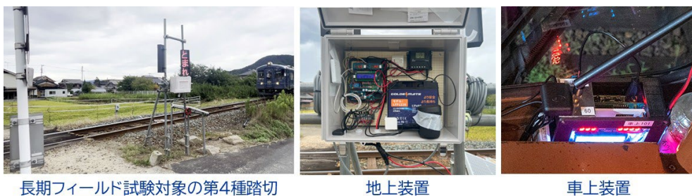
【図3 第4種踏切安全通行支援システムの長期フィールド試験の様子】
