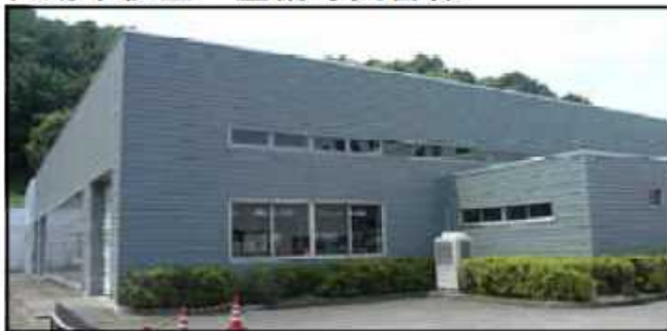
自動車検査・整備等実習棟
