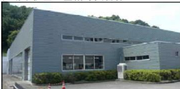
自動車検査・整備等実習棟
