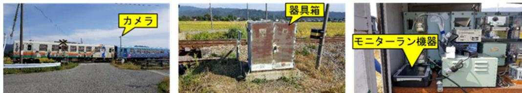
カメラの設置状況      モニターランの機器収納箱      機器収納状況
